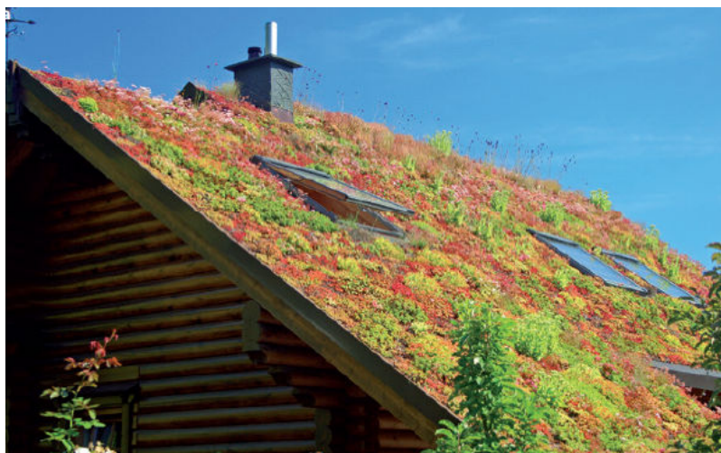
Figura 17. Tetto verde in falda
