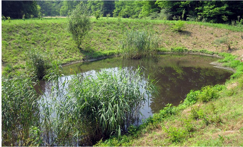
Figura 245. Bacino di infiltrazione e fitodepurazione
