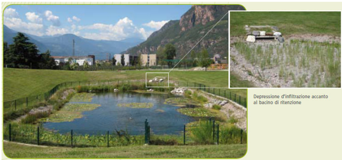
Figura 234. Bacino di ritenzione con infiltrazione artificiale
