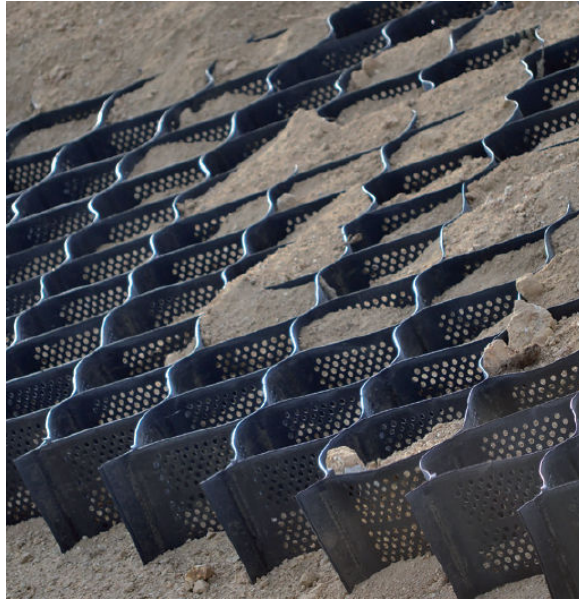
Figura 22. Sistema modulare geocellulare
